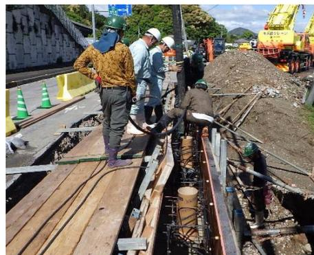
コンクリートの打設は、県道通行に影響が出ないようにポンプ打設としました。
