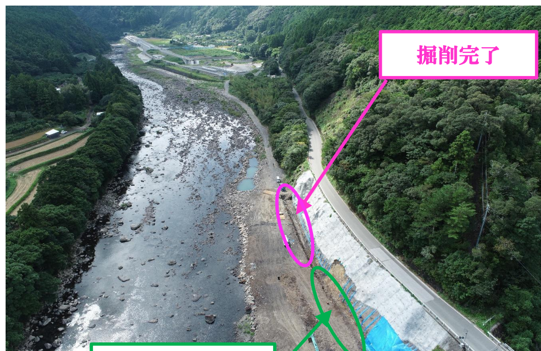
残りの掘削箇所
